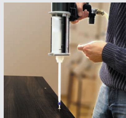
3. Подача клея с помощью сжатого воздуха
